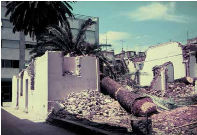
Med rušenjem starega sprednjega dela stavbe
